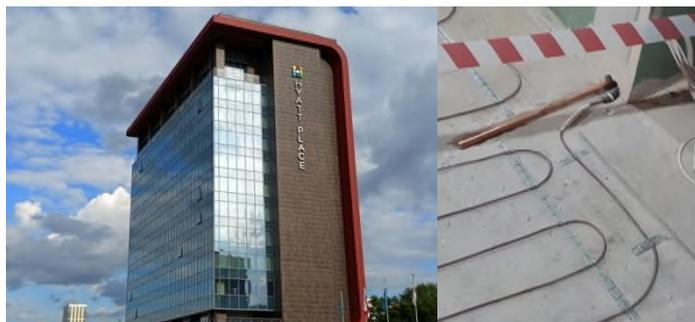
С помощью Silheat®С30 была выполнена система электрообогрева кровли и водостоков отеля, в желобах, а также входные группы и пандусы. Также осуществлена поставка системы электрообогрева нагревательного кабеля Silheat®S20 для санузлов отеля, зоны ресепшн.
