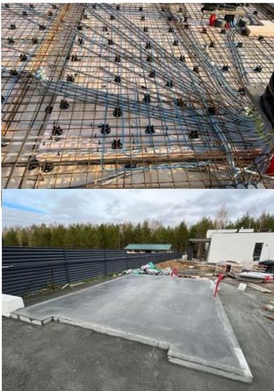
Применение электрообогрева в строительстве при бетонировании конструкций при ожидаемой среднесуточной температуре наружного воздуха ниже 5 °С согласно СП 70.13330.2012 п. 5.11.7. «Несущие и ограждающие конструкции» решает следующие задачи:
