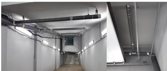
Был выполнен локальный электрообогрев трубопровода в подземном паркинге, в том числе на холодных участках при въезде нагревательным кабелем Silheat S20
