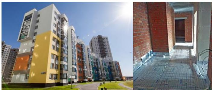
Проектирование, поставка оборудования (нагревательного кабеля SilheatS20), шеф-надзор и установка инновационной системы основного электрообогрева второго и третьего электродомов в г. Екатеринбурге
